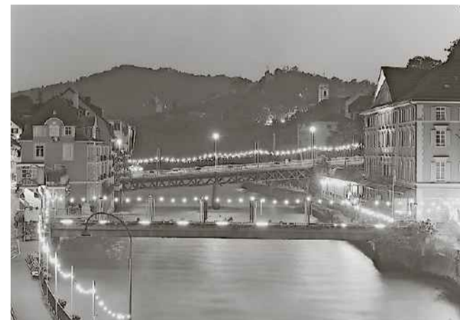
Verbindendes und Trennendes: Der Mercier-Steg (vorne) und die Schiefe Brücke, festlich erleuchtet zum Bäderfest 1985. Der Steg wurde 1968 gebaut, um das Ennetbadener Abwasser nach Baden zu führen.
