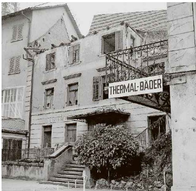
Auch ein Stück Ennetbadener Geschichte: Der Niedergang des Kurbetriebs im 20. Jahrhundert war unaufhaltsam – nicht zuletzt wegen des Durchgangsverkehrs. Hier der Abbruch der Dépendance des «Hirschen», dem früheren Gasthaus Sternen, im Jahr 1976.
